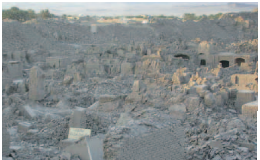
Habitations, écoles, magasins, bâtiments médicaux et administratifs de Bam et des villages environnants ont été détruits à 85 %
