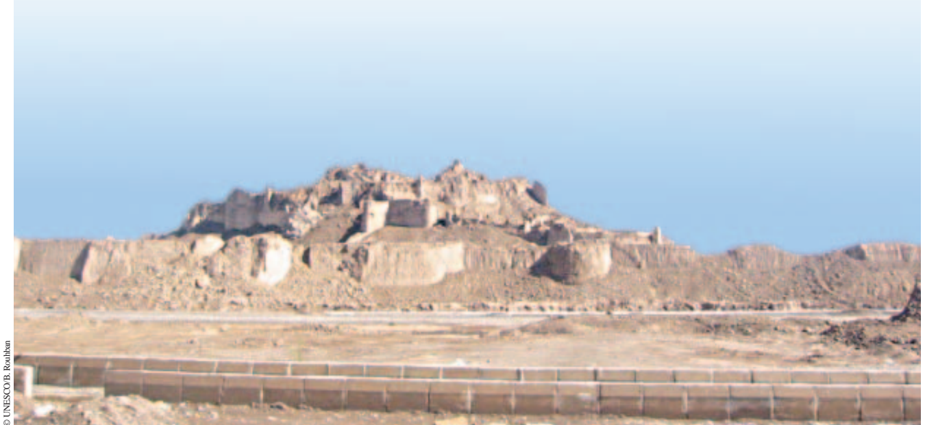
La citadelle de Bam très endommagée (Arg-e-Bam)
